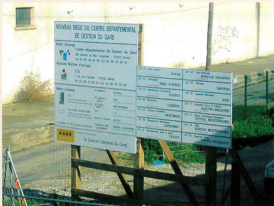
Le panneau de chantier, premier acte des travaux.
