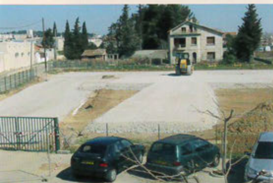
D'un terrain vague aux travaux de terrassement
