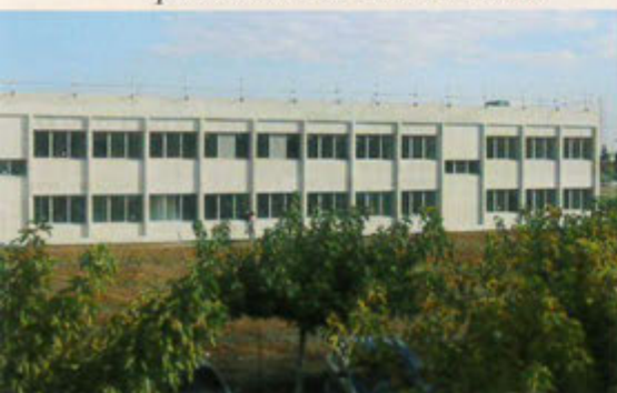
Face ouest, fin du gros oeuvre
